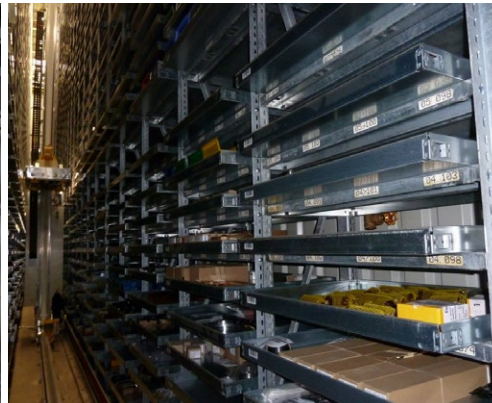
Nach dem Umbau: Neue Tablare, die auf den vorhandenen Fachböden gelagert werden. After retrofit: New trays to be stored on the existing rack shelves.
