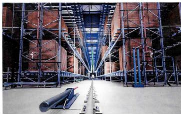
▲ Das Regal ist so konstruiert, dass die Wellpappenstapel durch geeignete Profile so unterstützt werden, dass keine Beschädigung der Pappe entsteht
