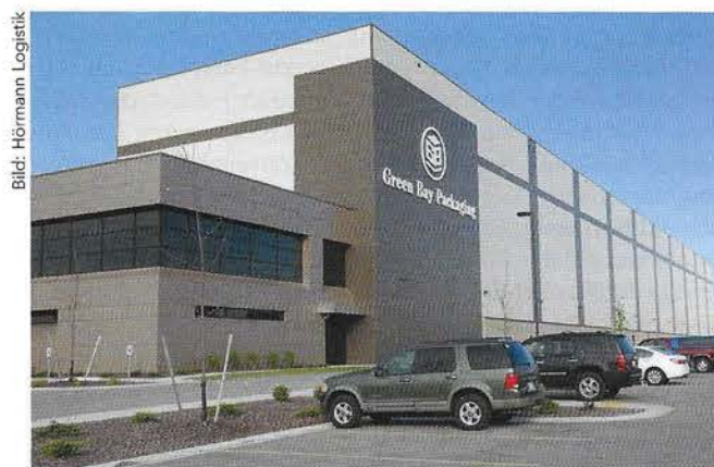
Der Baubeginn des neuen Hochregallagers bei Green Bay Packaging erfolgte im April 2014. Der Produktivbetrieb begann in Stufen ab Mai 2015 und wurde 2016 abgeschlossen. Die Realisierung und Inbetriebnahme wurde permanent von einem Hörmann Logistikteam vor Ort begleitet und betreut.
